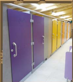
la porte PMR
