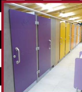
la porte Pmr
